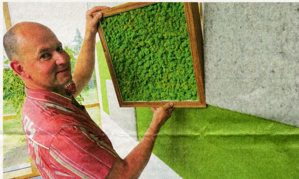
Mirko Schlosser bringt eine mit echtem Moos gestaltete Platte zwischen den Dämmplatten an die Wand an. Das Besondere: Die Paneele sind aus Schafwolle und verbessern unter anderem das Raumklima.
